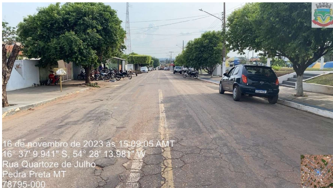
3 - Rua Marechal Rondon - Trecho Inicial.
