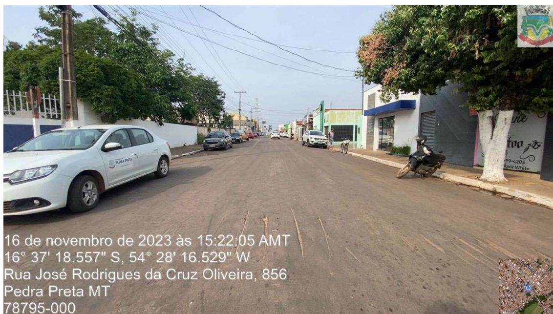
11 - Rua José R. da Cruz Oliveira – Trecho Final.
