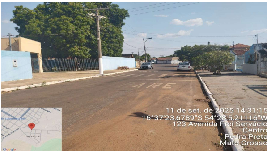
21 – Rua Sinomar Custódio(Creche Arlindo Domingos) - Passagem de Faixa de Pedestre Elevada
