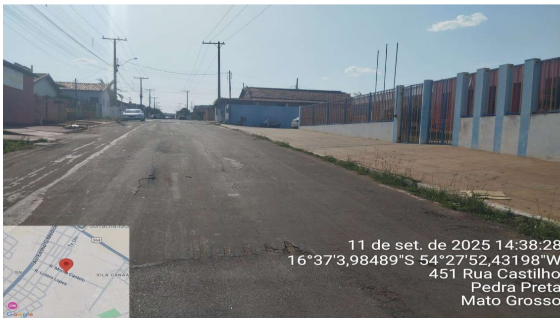
23 - Rua Nivaldo Ramil(CIMEI José Luiz Barcara Filho)- Passagem de Faixa de Pedestre Elevada
