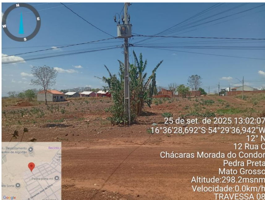
(FOTO 01: frente da travessa 08)
